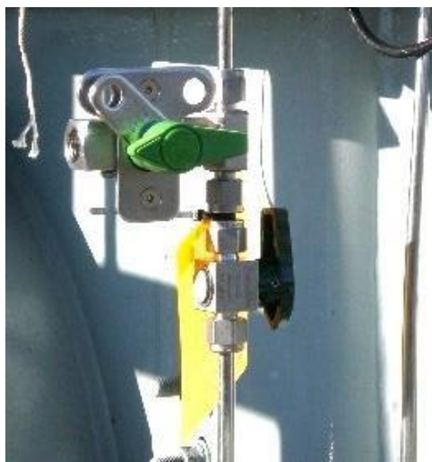
Рисунок 11: Клапан ручной выборки / вторичный запорный клапан
