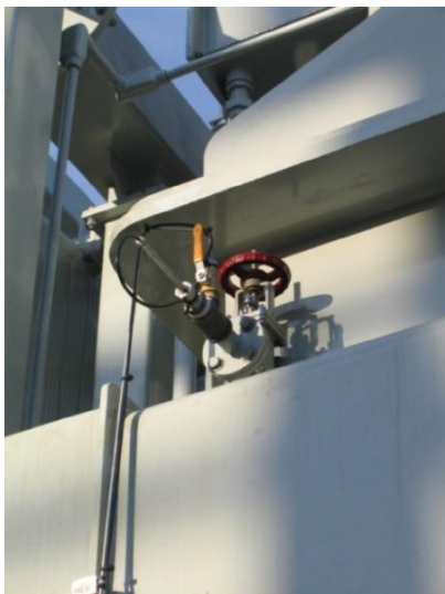
Рисунок 9: Вкладка «Адаптер подачи масла» Рисунок 10: Масляный редуктор / отводящая арматура
